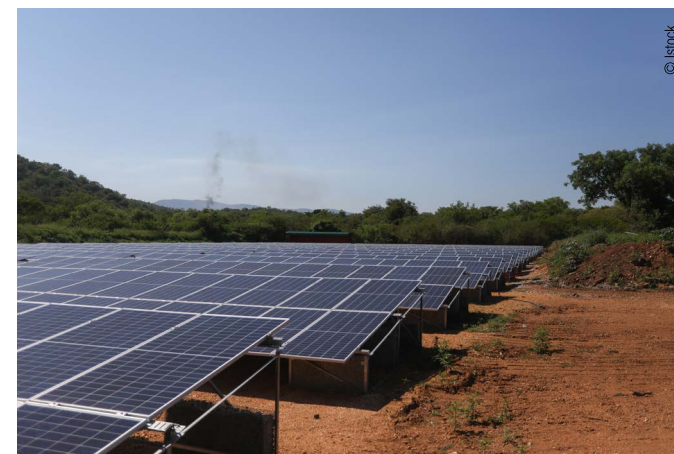
Installation de panneaux solaires en Afrique
